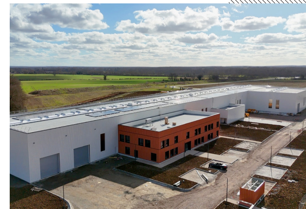
Usine Soprema à Étretchet (en cours)
