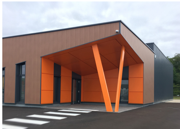
Entrepôt artisanal à Guénange
