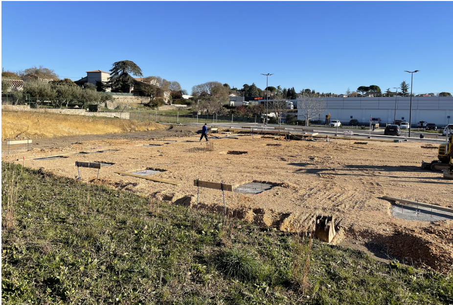
Fondations superficielles, avancement VRD gros œuvre, décembre 2023
