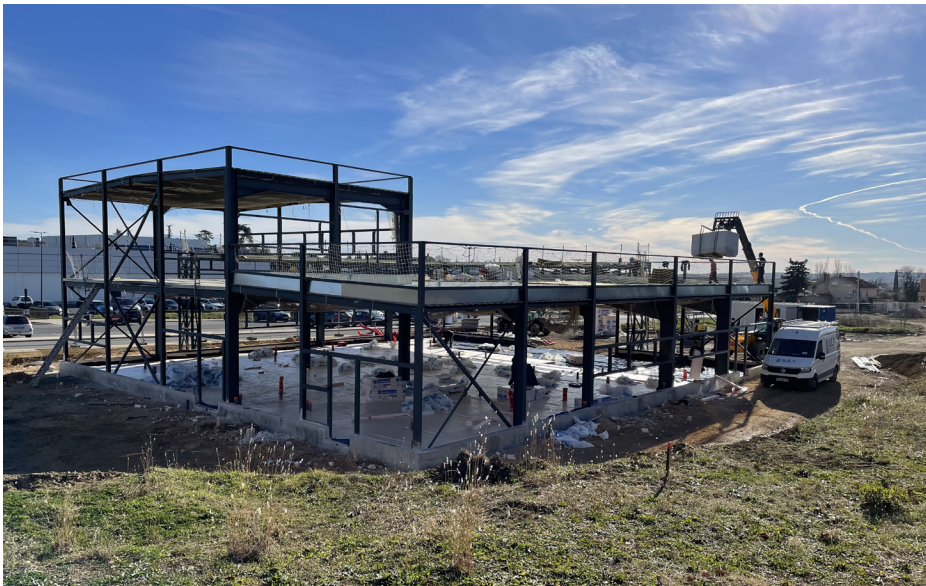
Dallage B.A. sur terre-plein et isolation et montage de l'ossature, janvier 2024
